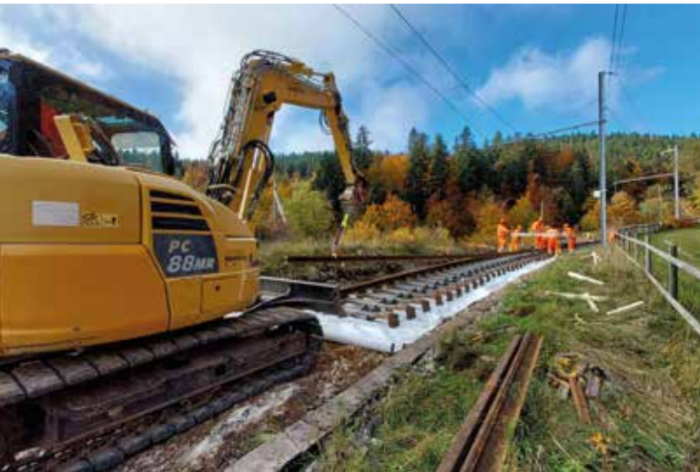
En 2025, c'est environ 1,4 kilomètre de voie qui a été équipé d'une infrastructure neuve. (© NStCM)
